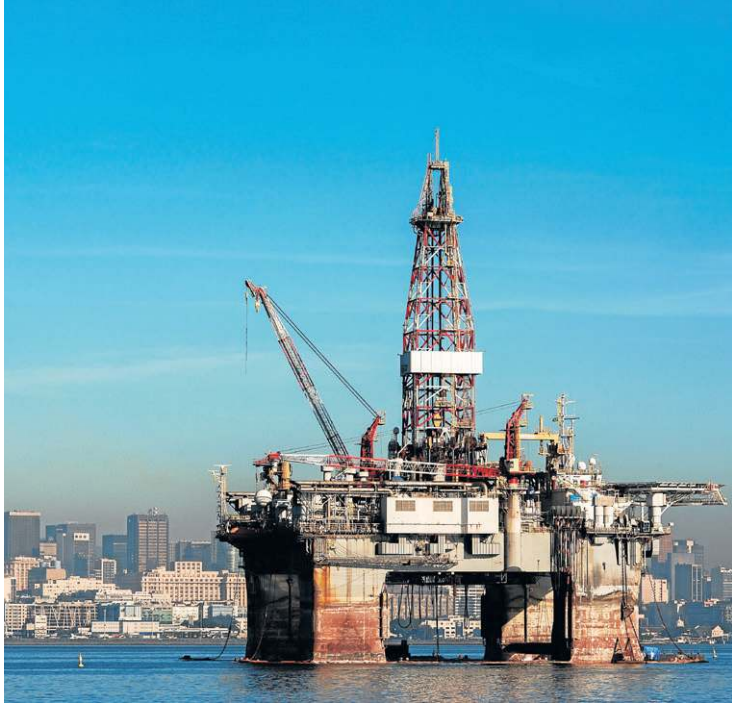
A perfuração dá continuidade aos trabalhos da primeira descoberta
