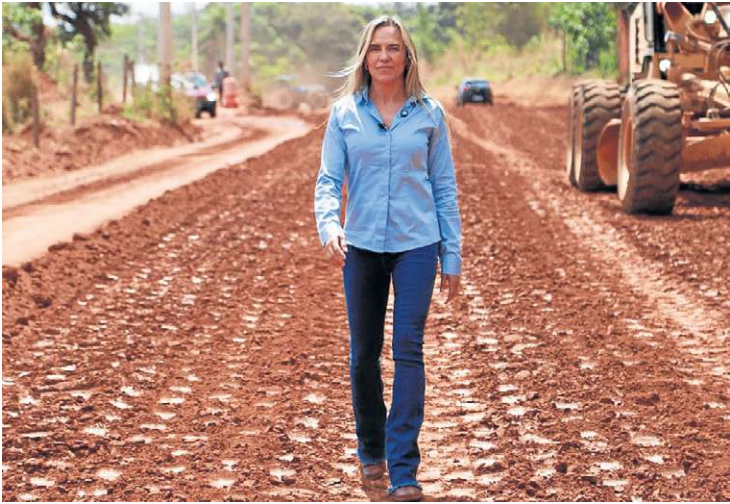
Celina visitou a obra de pavimentação da VC-351
