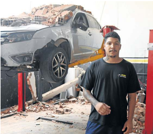
Diego Lopes: parede foi derrubada em oficina
