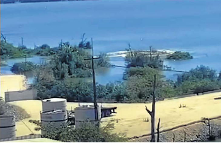
Colapso de mina, em 2018, afetou manguezal do litoral alagoano
