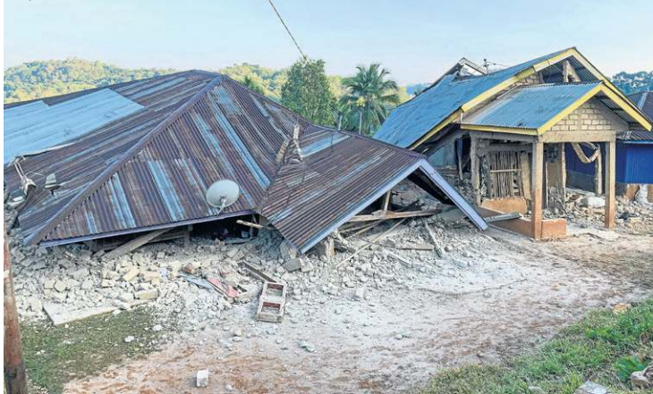
Casas colapsadas na cidade de Ruteng, onde Leonardus e Paulus moram
