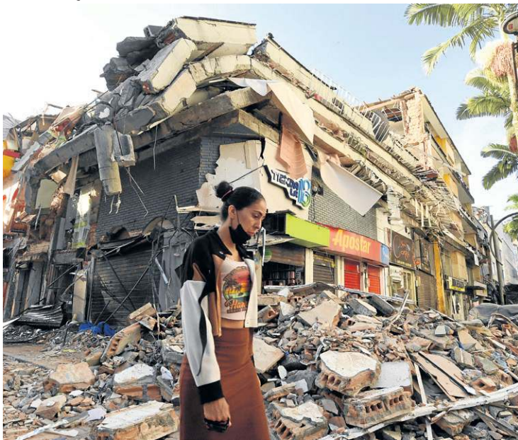
Mulher caminha diante de edifício em ruínas, no mesmo município
