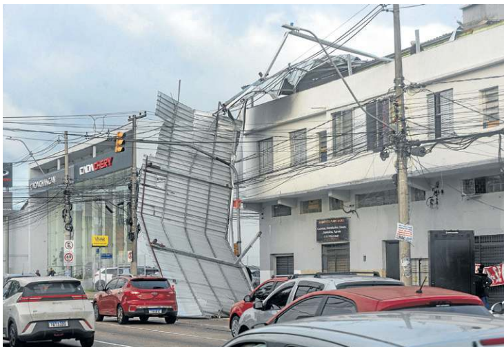
“Ciclone-bomba” deixou um rastro de destruição em Porto Alegre
