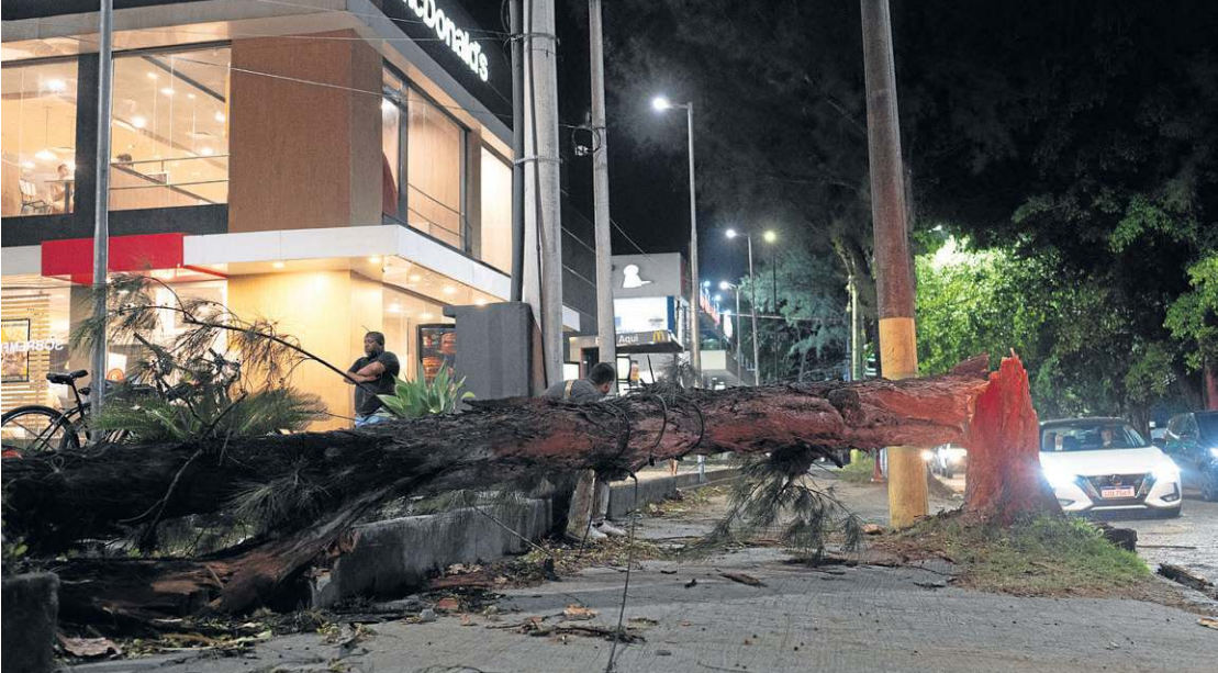
Vendaval no Rio derrubou postes e árvores sobre a rede elétrica. Vários bairros passaram o dia sem energia
