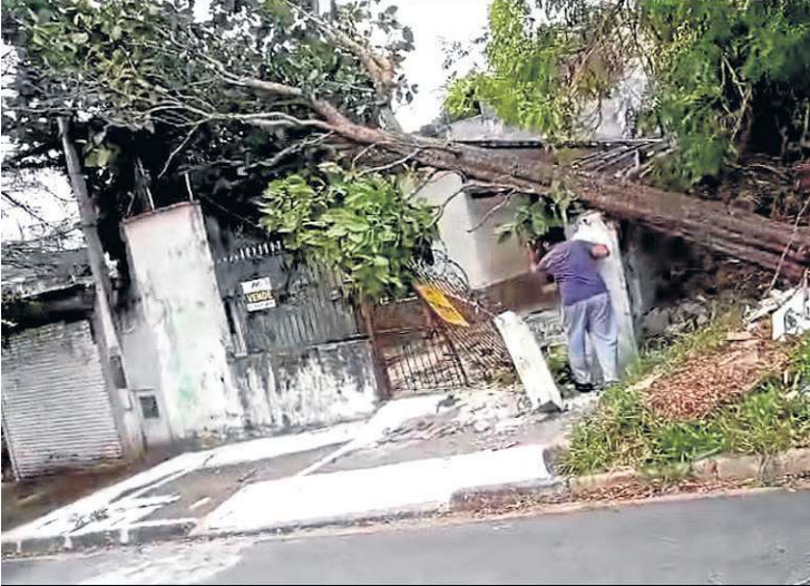
A forte rajada de vento atingiu o Alto Tietê, em SP, derrubando muros
