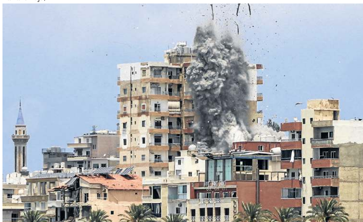
Destruição após bombardeio a prédio na cidade libanesa de Tiro
