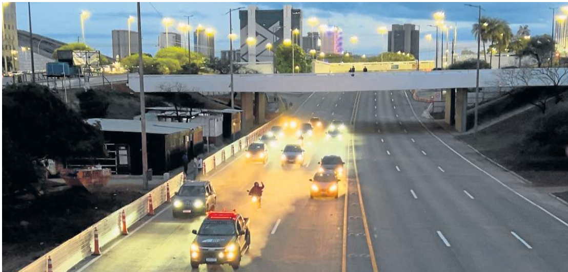
Obras no local tiveram início há dois anos, em junho de 2024. Conclusão está prevista para julho deste ano
