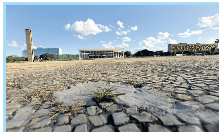
Trabalhadores terão de tirar parte cimentada no espaço público e recolocar novas pedras vindas de Minas
