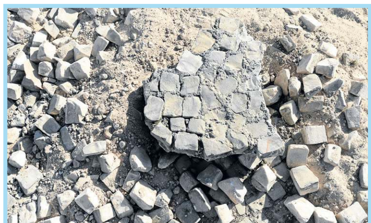
Pedras que não puderam ser reaproveitadas por estarem rejuntadas com concreto
