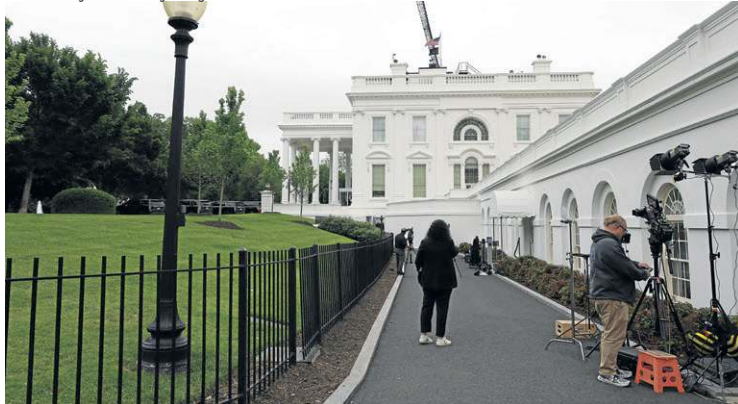
Guindaste sobre o telhado da Casa Branca: impasse sobre obras
