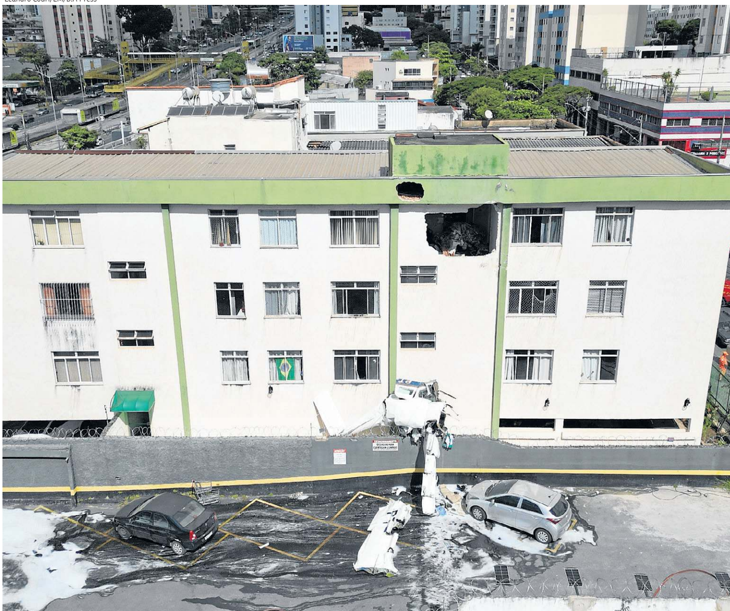
Com o impacto, o avião abriu um buraco no terceiro andar do edifício do Bairro Silveira, em Belo Horizonte: nenhum morador foi atingido
