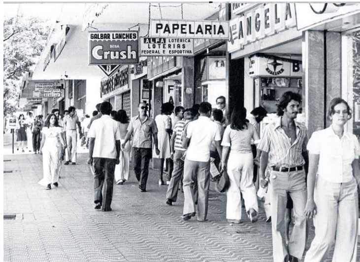
Movimentação na W3 Sul, em 1975: primeira a ser construída
