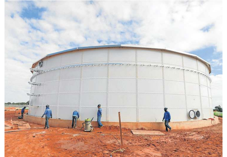
Obras de ampliação do sistema de abastecimento na região norte
