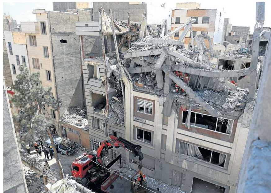
Bombeiros buscam vítimas e inspecionam danos em prédio destruído, em Teerã
