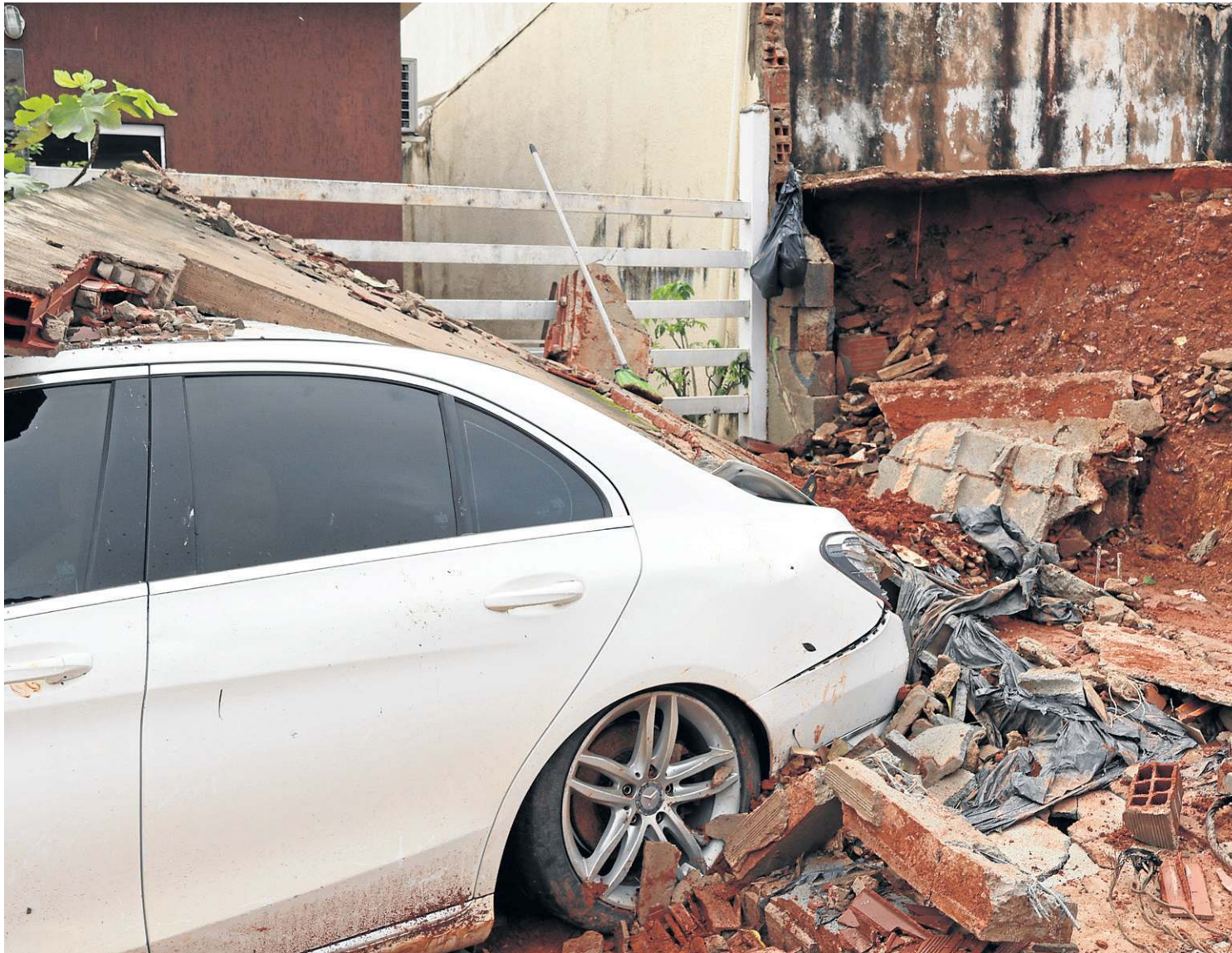
Força da chuva derrubou um muro de 6 metros de altura sobre um carro estacionado na garagem em Vicente Pires
