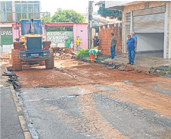
...uma força-tarefa esteve no local para a retirada do asfalto
