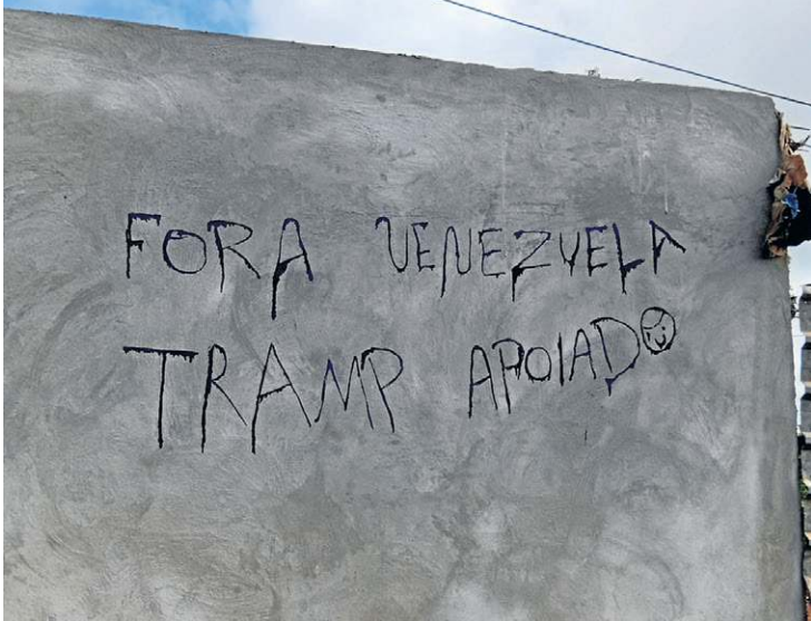
Muros pichados: “Fora Venezuela, Trump (sic) apoiado”...
