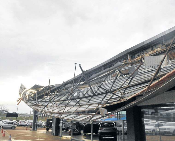
Ferragens foram retorcidas e se inclinaram com a força do vento
