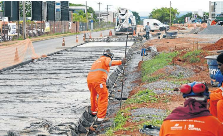
Obras na Epig: concretagem da pista exclusiva para o BRT
