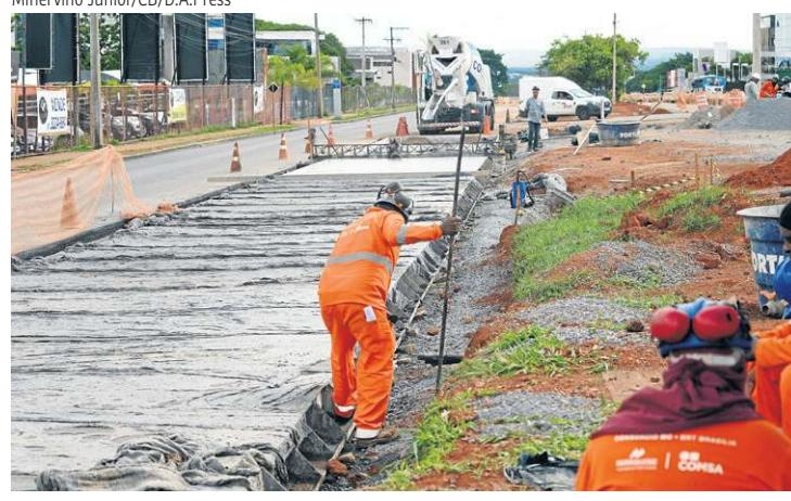
Obras na Epig: concretagem da pista exclusiva para o BRT
