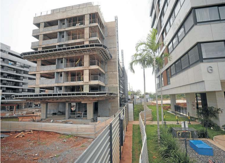
Canteiro de obras na quadra 500 onde o incidente ocorreu
