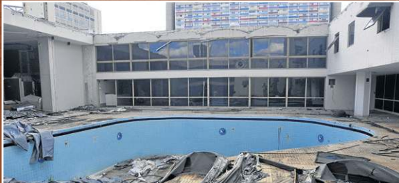
Piscina em obras
