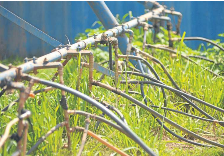
Água de caminhões-pipa se contamina ao entrar nas mangueiras
