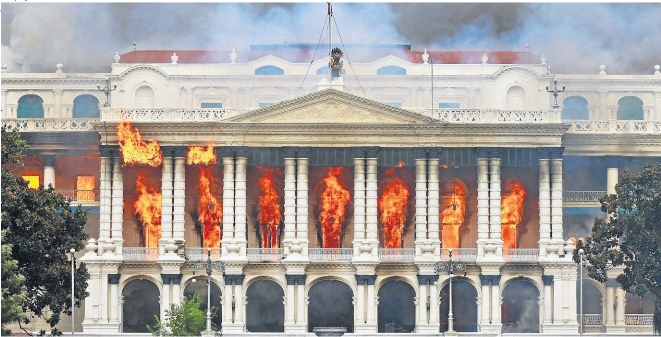
Fogo se alastra no Singha Durbar, principal prédio do governo, em Katmandu: Geração Z expressa ira por bloqueio às redes sociais
