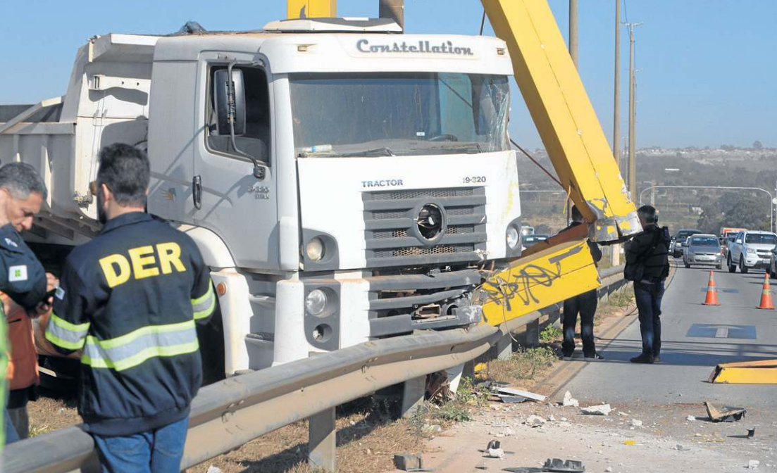
Segundo o DER-DF, a colisão não afetou a estrutura metálica da passarela, mas danificou o pilar atingido
