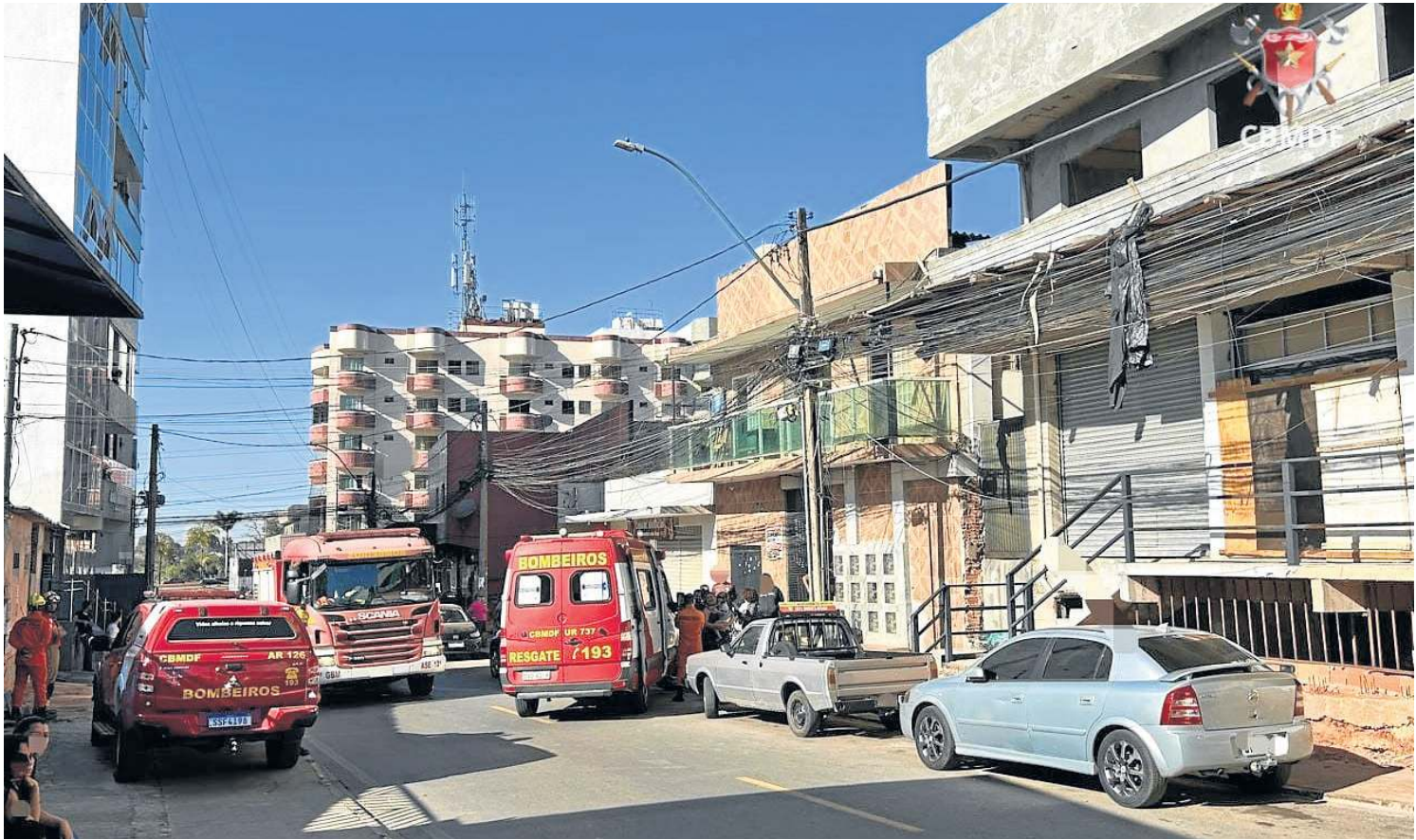
O homem foi encontrado sem vida no fosso de um elevador em prédio com construção embargada de Vicente Pires
