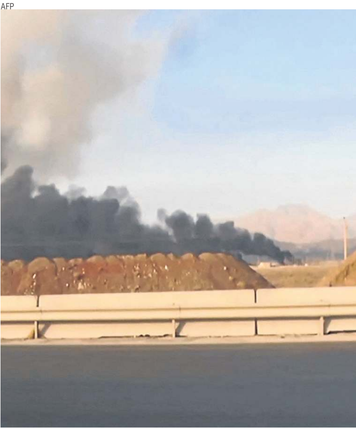
Coluna de fumaça após explosões na usina de Natanz (centro)
