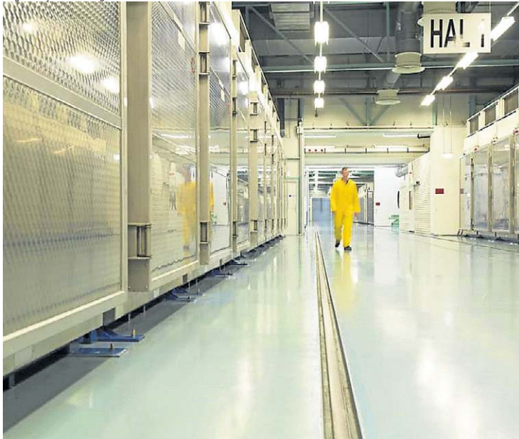
Interior da usina de Fordo, localizada cerca de 180Km ao sul de Teerã
