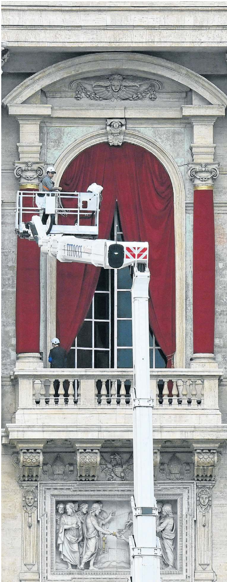
Cortinas foram instaladas ontem, no balcão da Basílica de São Pedro
