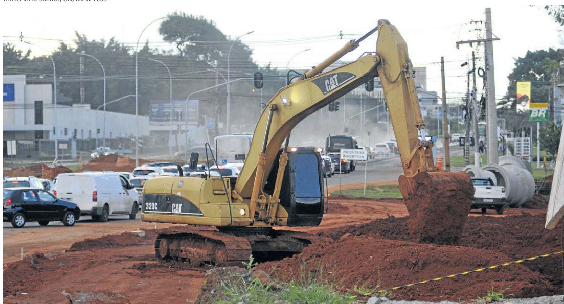
Cerca de R$ 160 milhões serão investidos nas obras na Epig, que começaram em abril de 2023
