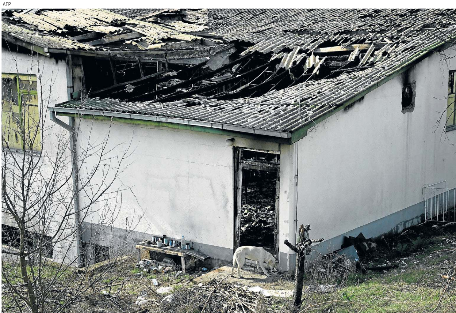
250 ingressos foram vendidos, mas havia 500 pessoas na casa noturna. Falta de saídas de emergência impulsionou o número de mortes
