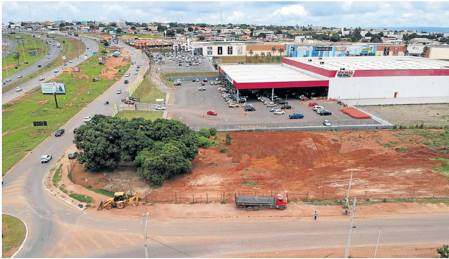
Terreno onde será construído o Itec — pavilhão de exposições permanente com área de 8.600m², ao lado do Shopping de Águas Lindas
