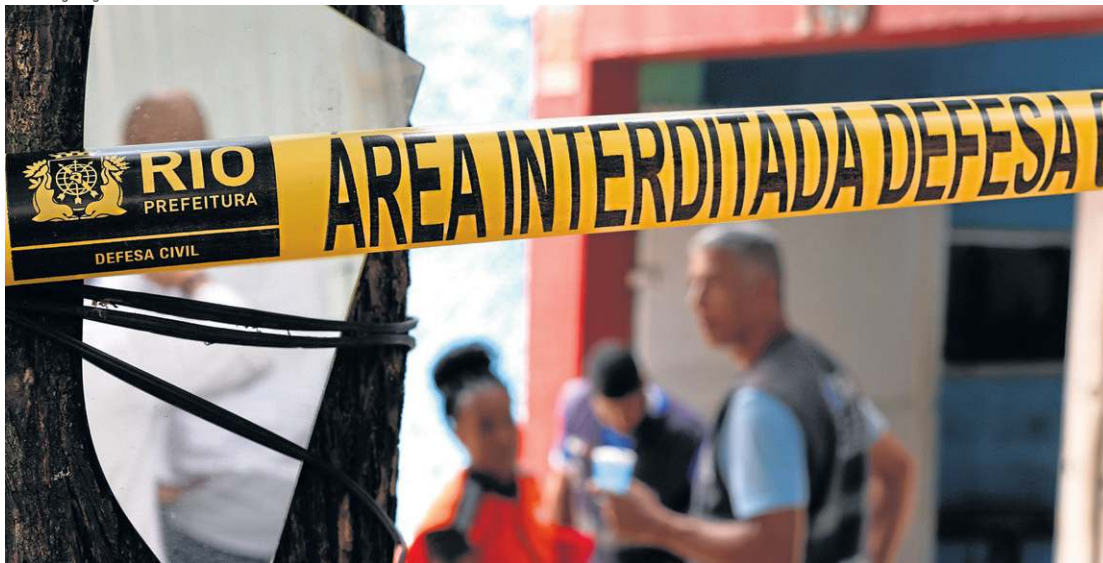
Prédio da Maximus Confeções foi interditado para ser periciado e porque corre o risco de desabar
