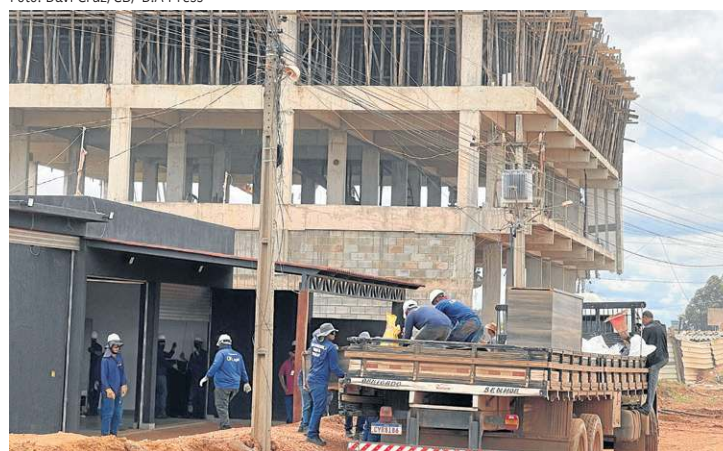
A ação da DF Legal continuará hoje, com a demolição de um prédio
