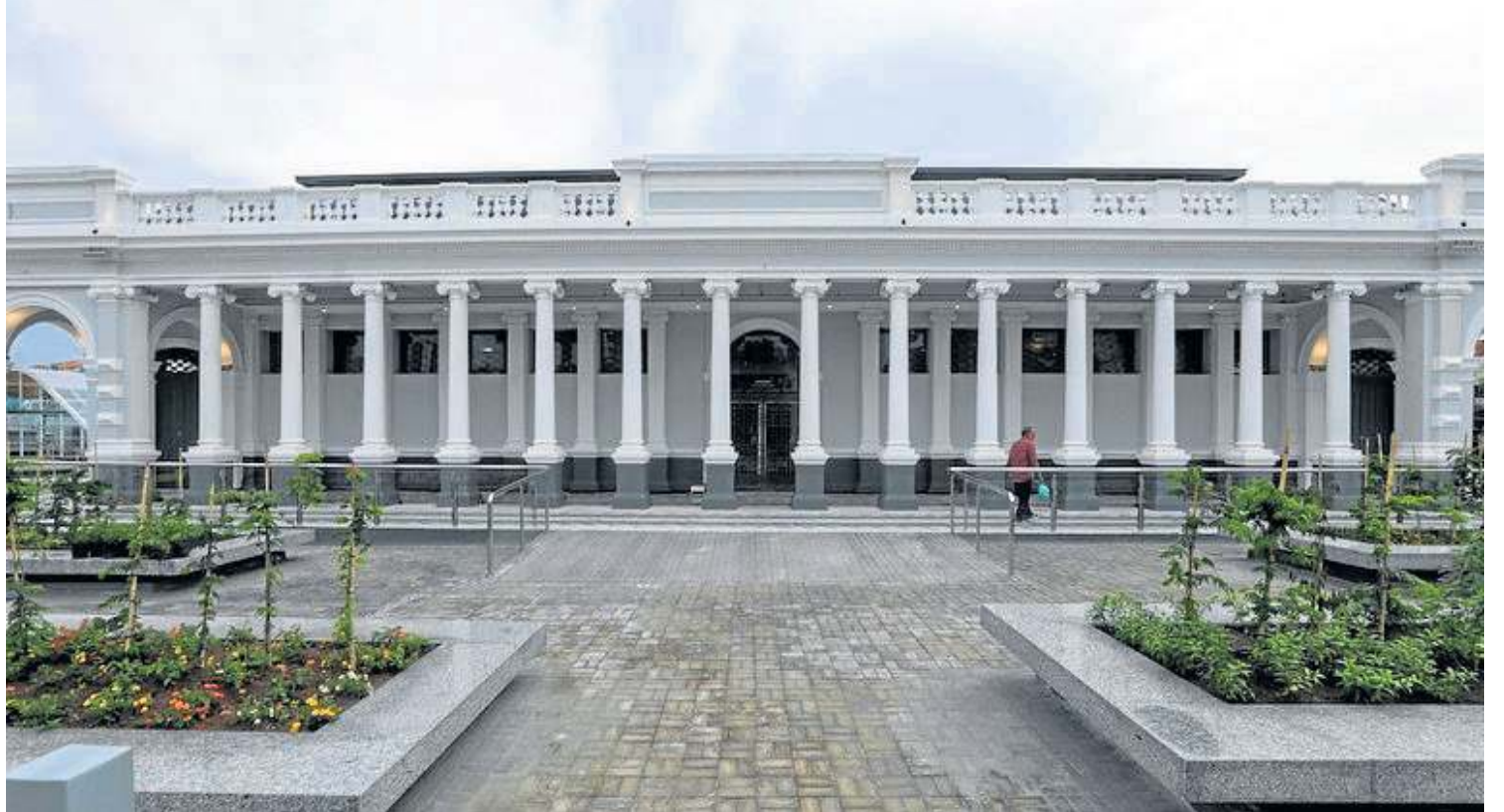
A primeira obra a ficar pronta para a COP 30, em dezembro do ano passado, foi a revitalização do Mercado de São Brás, em Belém
