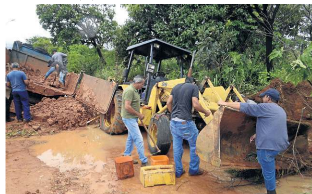
Tratores foram usados para desobstruir estrada na Ponte Alta
