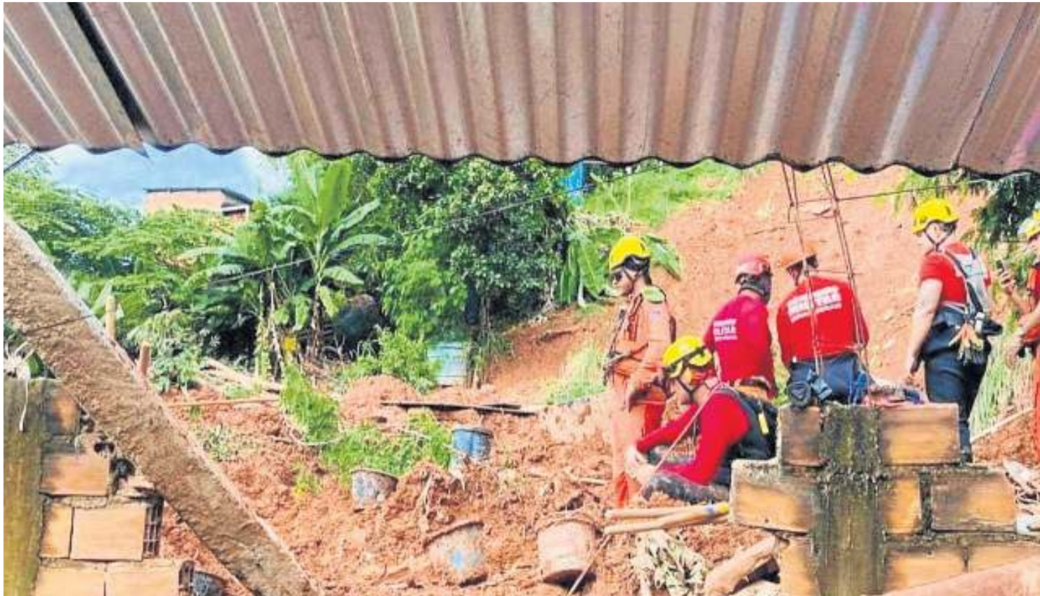
Equipes verificam desabamento de encosta em Ipatinga. Município mineiro é um dos mais afetados pelas chuvas que caem desde o fim de semana
