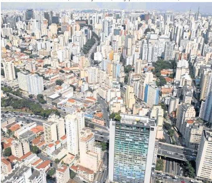
Espaços de concreto absorvem e retêm calor, inclusive, à noite
