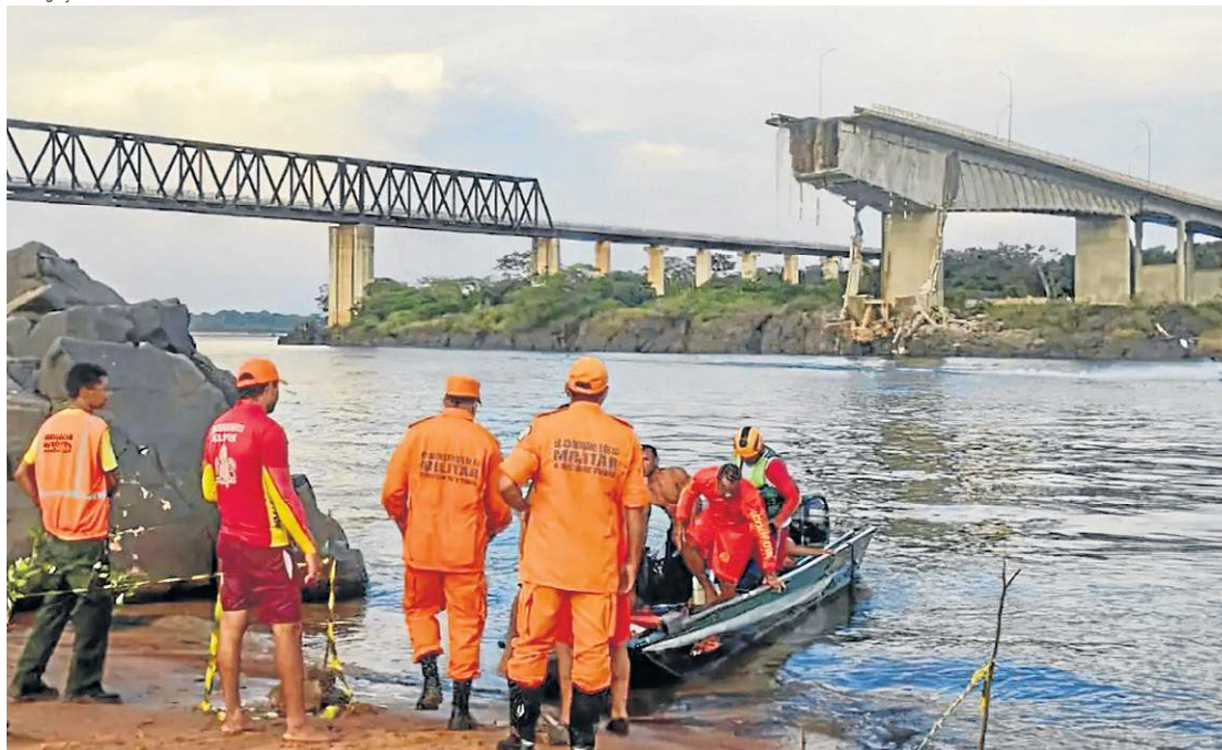
Ponte que liga Tocantins e Maranhão desabou no último domingo. Ao menos 11 pessoas seguem desaparecidas
