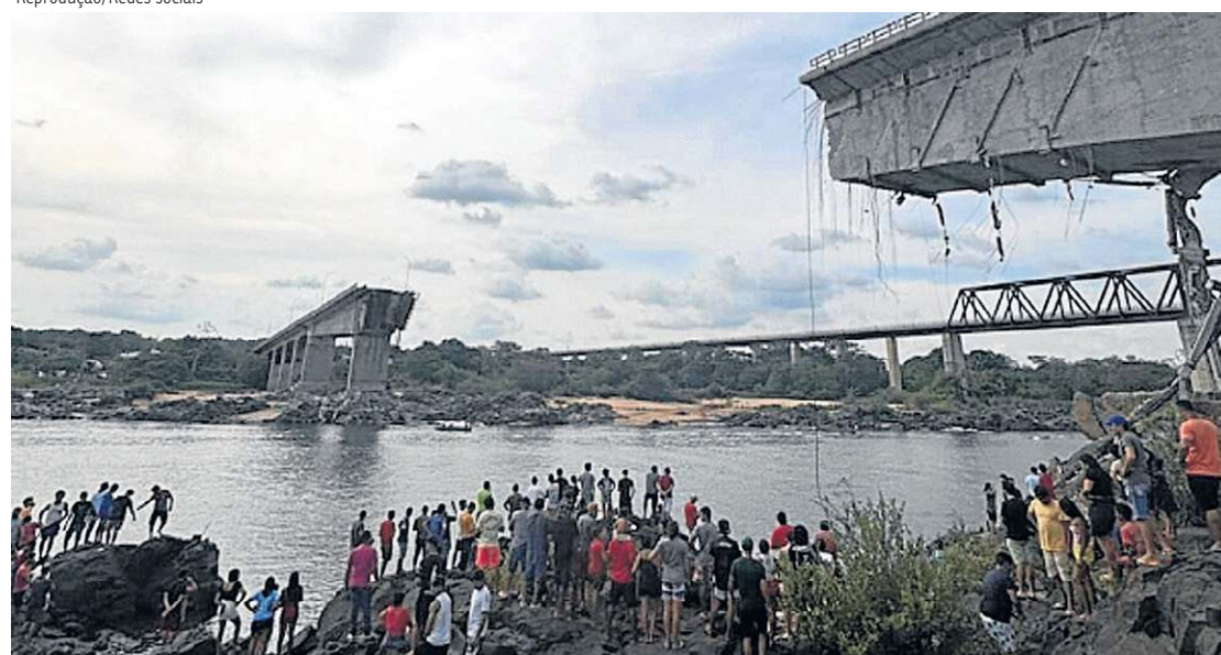
Estrutura que entrou em colapso foi inaugurada na década de 60. Três pessoas morreram na tragédia
