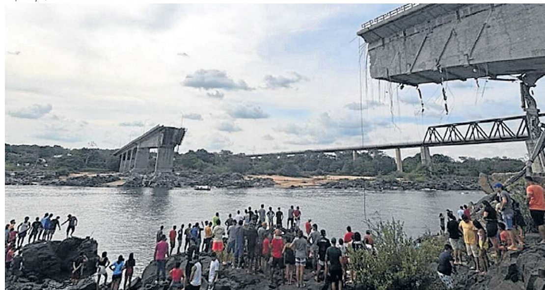
Estrutura que entrou em colapso foi inaugurada na década de 60. Três pessoas morreram na tragédia
