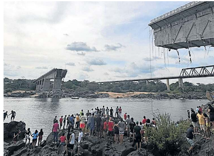
Estrutura que entrou em colapso foi inaugurada na década de 60
