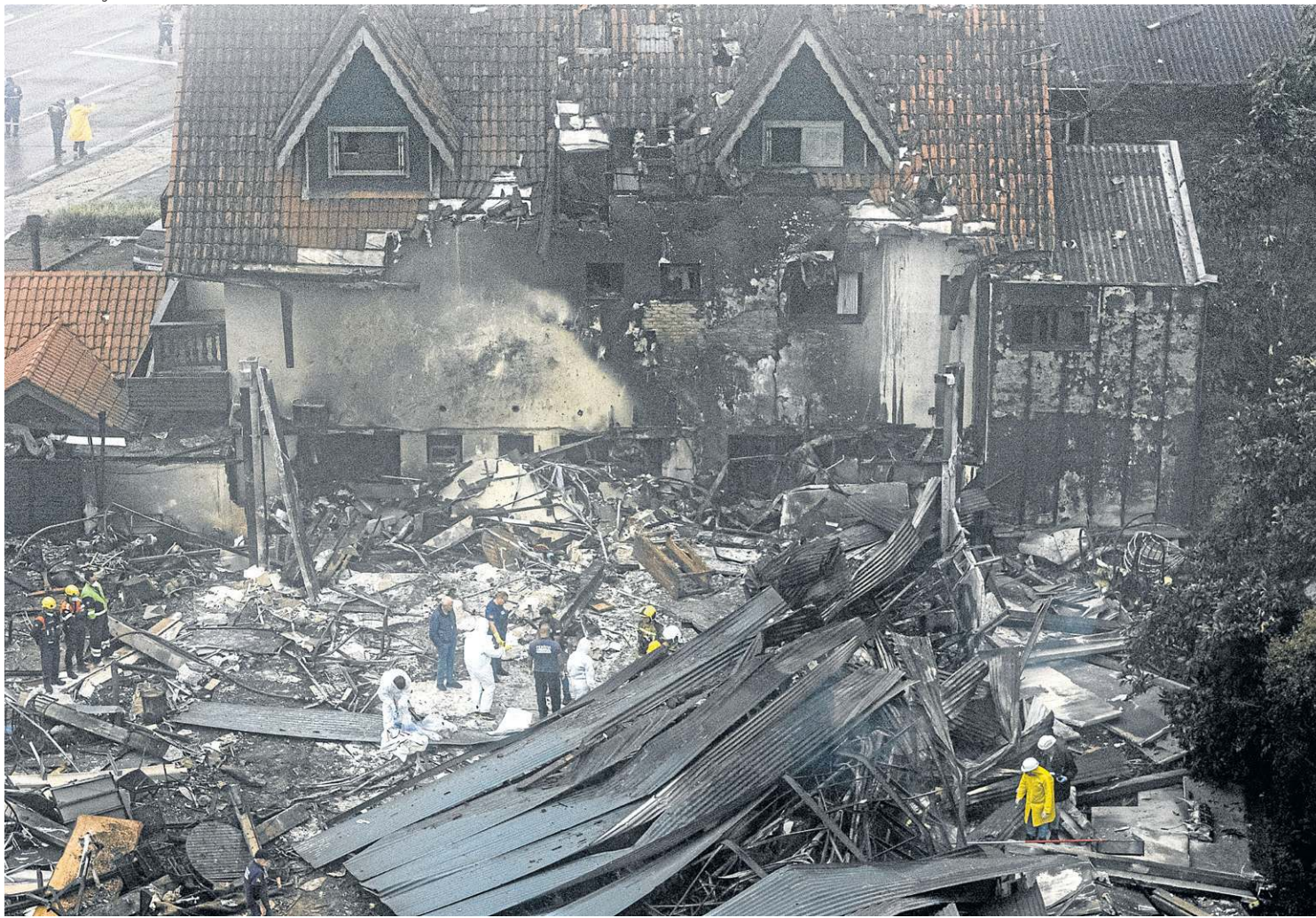
Aeronave caiu e atingiu a chaminé de um prédio, o segundo andar de uma casa e uma loja de móveis, além de destroços em uma pousada
