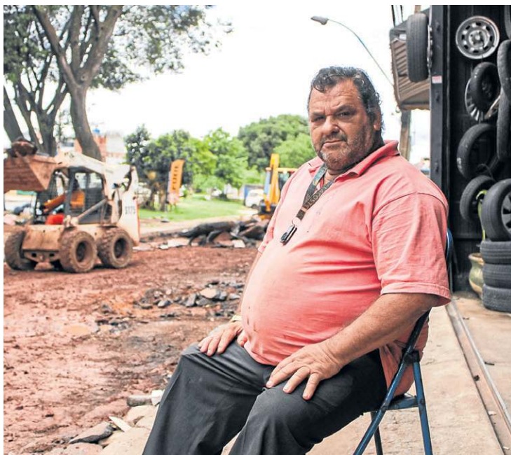
Ivan da Silva presenciou o momento em que o asfalto se quebrou
