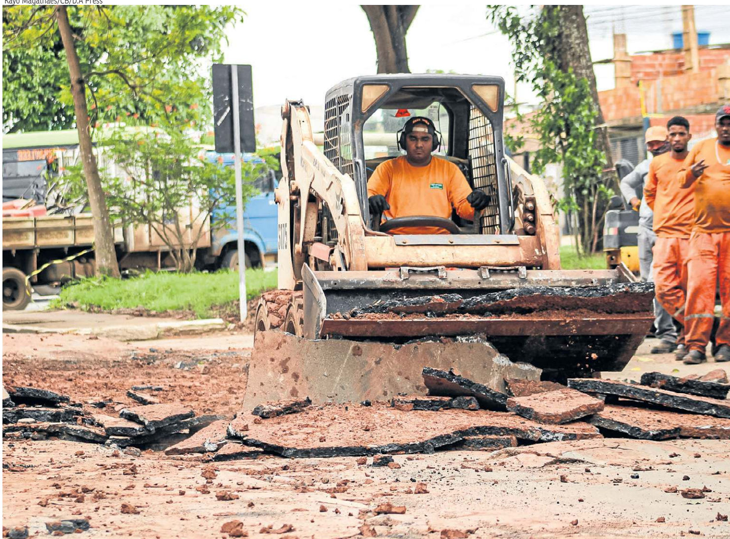
Novacap iniciou o restauro de asfalto danificado durante as fortes chuvas de domingo, no Sol Nascente. Governo criou uma força-tarefa
