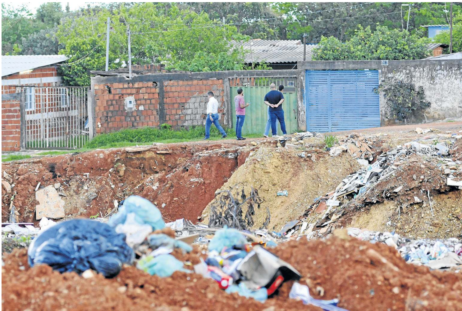
Abertura de uma cratera assustou moradores, ontem, no Trecho 3 do Sol Nascente, em Ceilândia. UnB e GDF monitoram 24 horas as erosões
