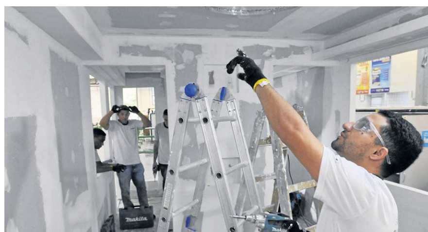
Aginaldo Gonçalves faz curso de construção em dry wall
